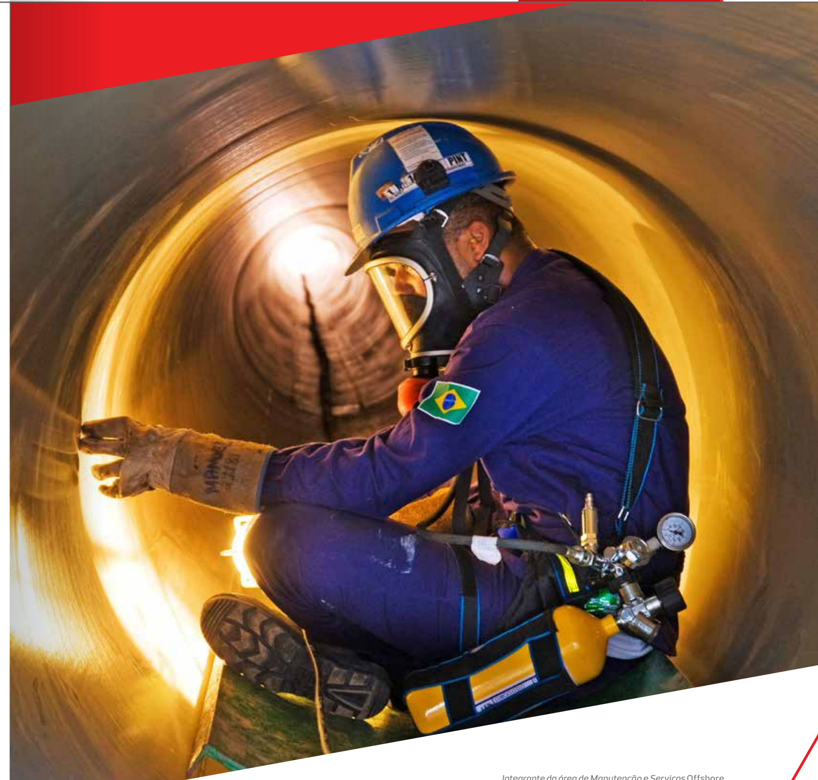
Integrante da área de Manutenção e Serviços Offshore
